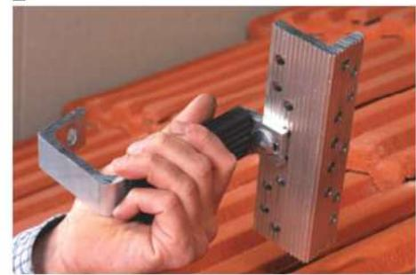
**3: Dachbügelkonsole einrichten und mittels Spax auf Sparren befestigen**
