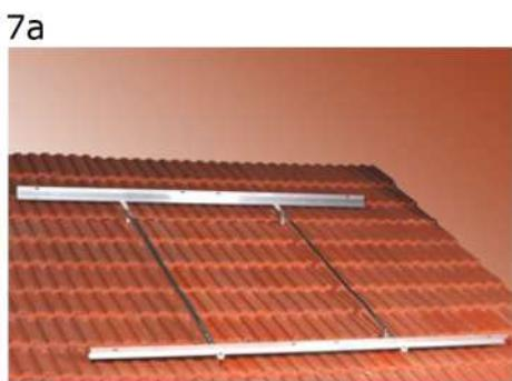
7: Trageschienen oben und unten mit der gerillten Fläche in die Klemmstücke einsetzen, ausrichten und fixieren
