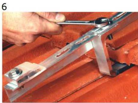
6: Auflagewinkel mit Dachbügel verschrauben
