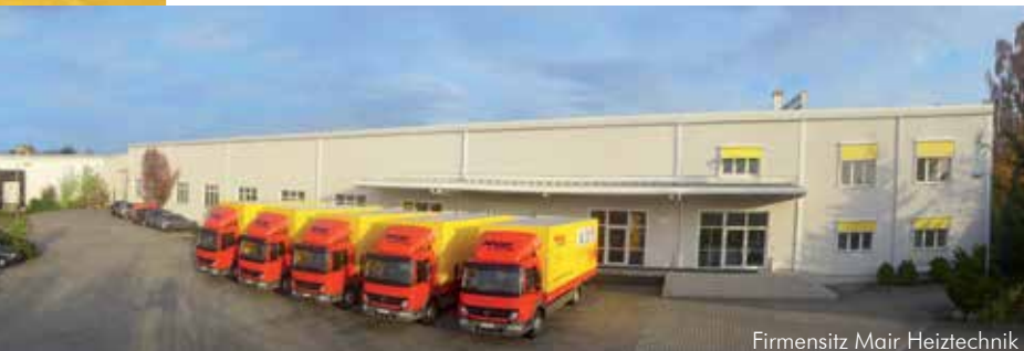
Firmensitz Mair Heiztechnik
