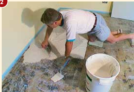
ThermoFloor Spezialkleber aufspachteln
