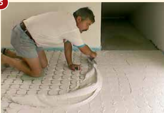
ThermoFloor Spezialkleber einspachteln
