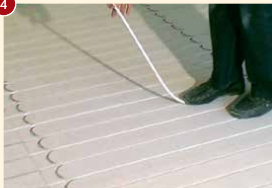
Multiflex-Verbundrohr einlegen
