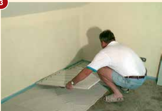
ThermoFloor Module verlegen
